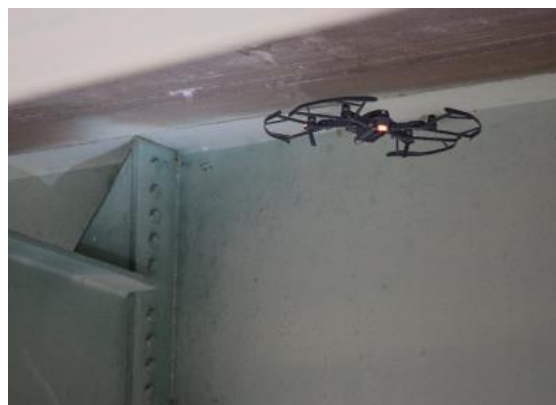
Fig. 1 Inspeção utilizando VANT. Fonte: Dorafshan, 2018 [32].
