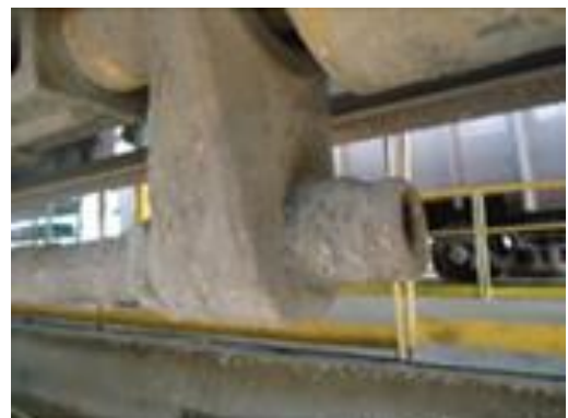
Fig. 1 Foto da biela travada por contaminação e oxidação.
