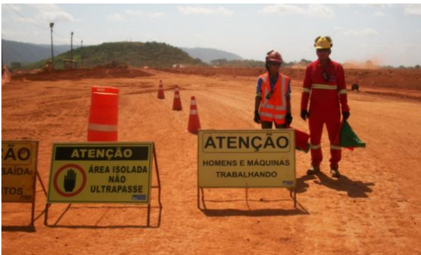
Fig. 1 Isolamento de frente de serviço
