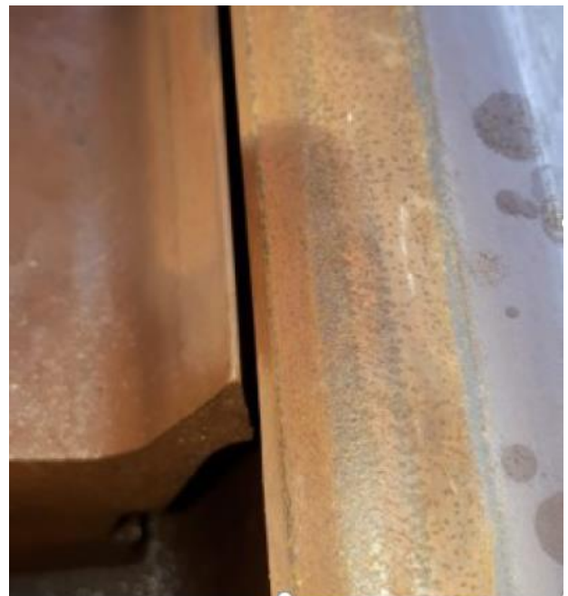
Fig. 9 Abertura entre Parte Móvel e Trilho de Encosto
