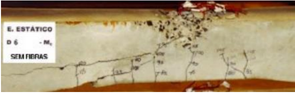
Fig. 4 Fissuração na região de central do dormente (Fonte: [4])
