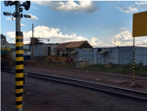
Fig. 7 Instalação em Brucutu
