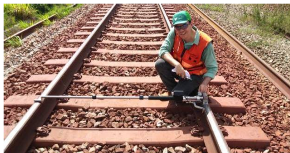
Fig.2 Inspeção de campo na curva LCC
