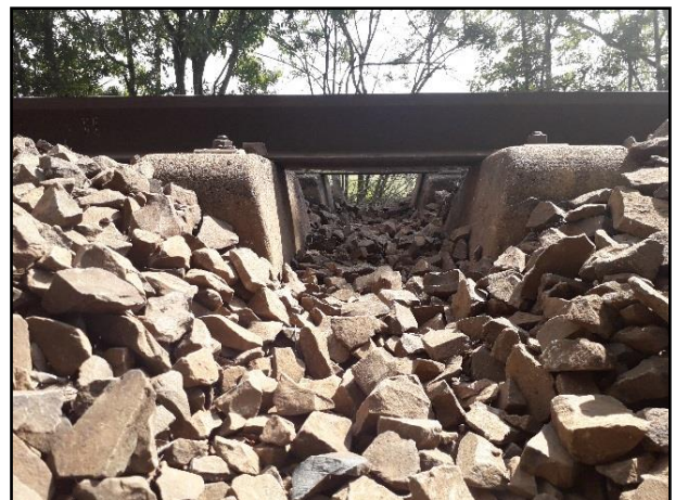
Foto 2- Rebaixamento do lastro até a cota base do dormente.
