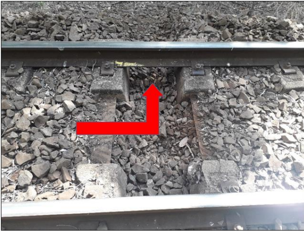
Foto 3 - Suavização do declínio na parte central, aumentando à medida que se aproxima do trilho.
