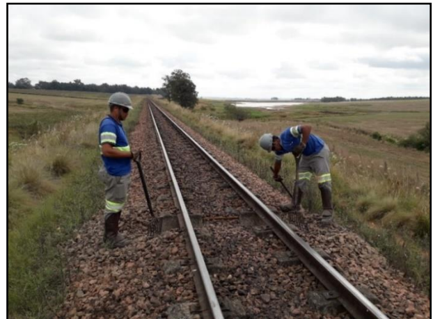
Foto 1 - 1ª Etapa: Remoção do lastro entre os dormentes.
