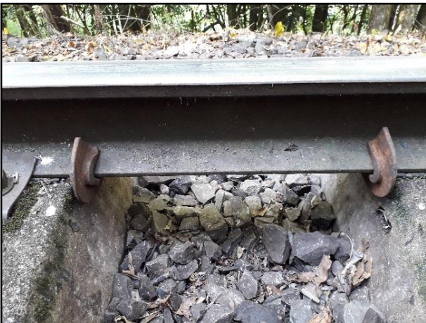
Foto 4 - 2ª Etapa: Aplicação de retensores no trilho para travamento dos dormentes.
