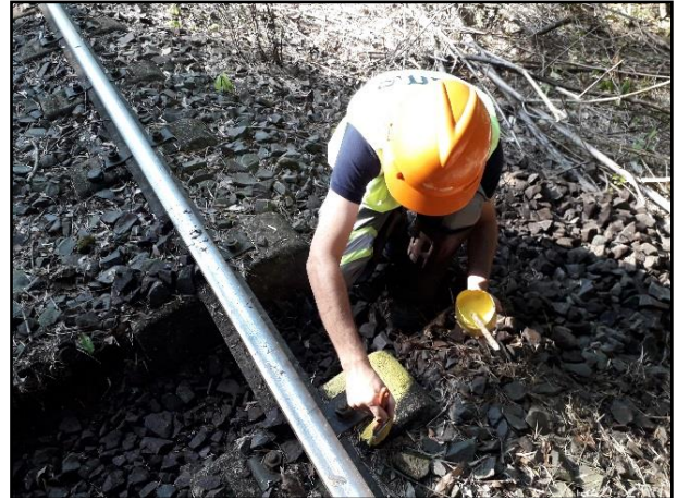
Foto 5 - 3ª Etapa: Sinalização com tinta para piso de coloração amarela nas pontas dos dormentes.
